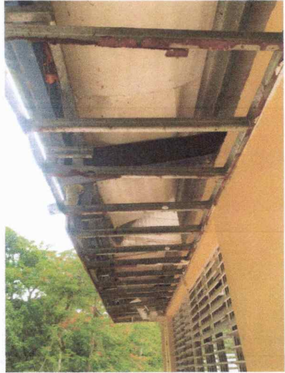
Reparación del Plafón exterior
