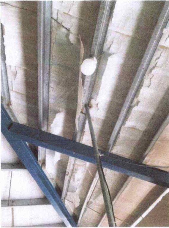
Reparación de plafón Interior
