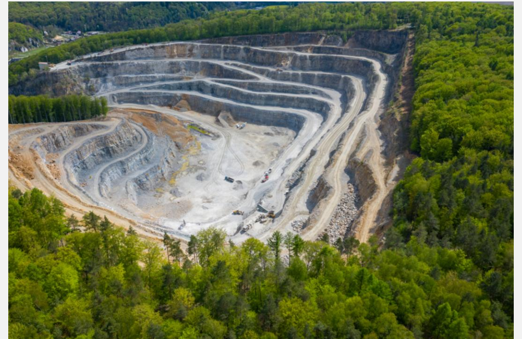
Desarrollo inicial (primera excavaciones y extracción inicial) del tajo y construcción de facilidades mineras
